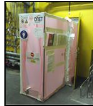
SAS de sortie compartiment TA
