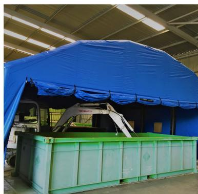
Grâce à sa technologie de conception avancée, le SAS gonflable permet aux utilisateurs de **réduire leur temps d'exposition et de répondre à des besoins de confinement** lors de travaux de maintenance et de déconstruction.
