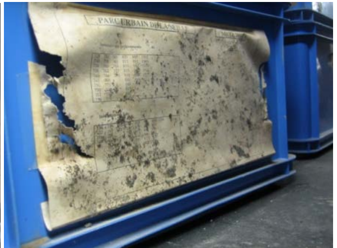
Moisissure noire et dégradation des fiches d'inventaires
