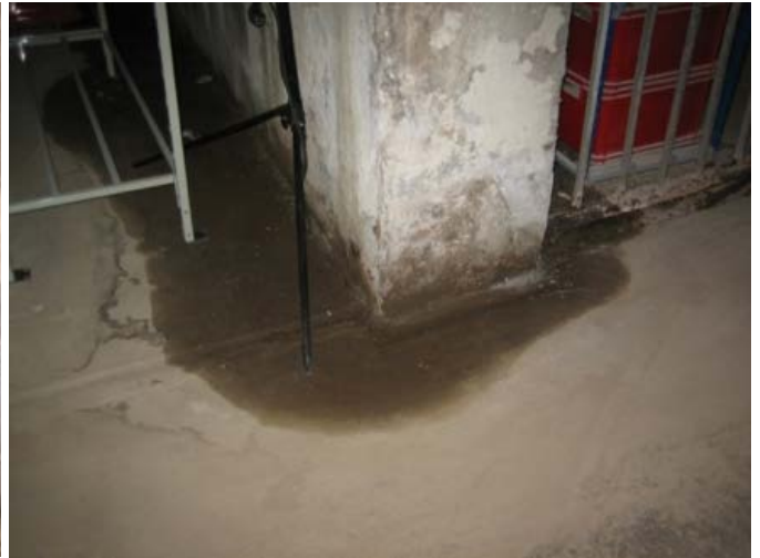
Stagnation de l'humidité niveau 2
