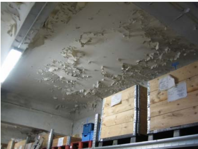
Ecaillage des peintures du plafond
