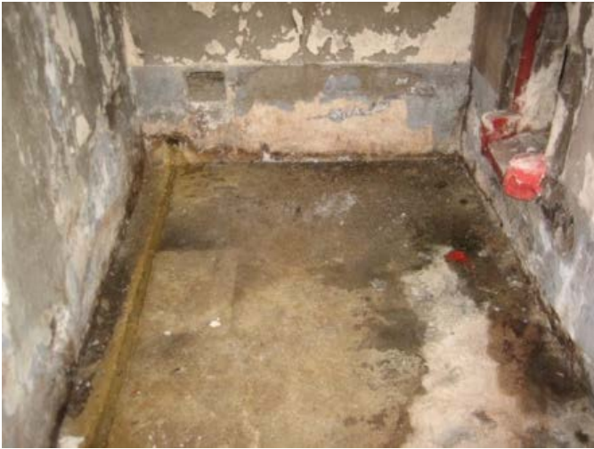
Naissance de la source d'eau vive réserve niveau -1
